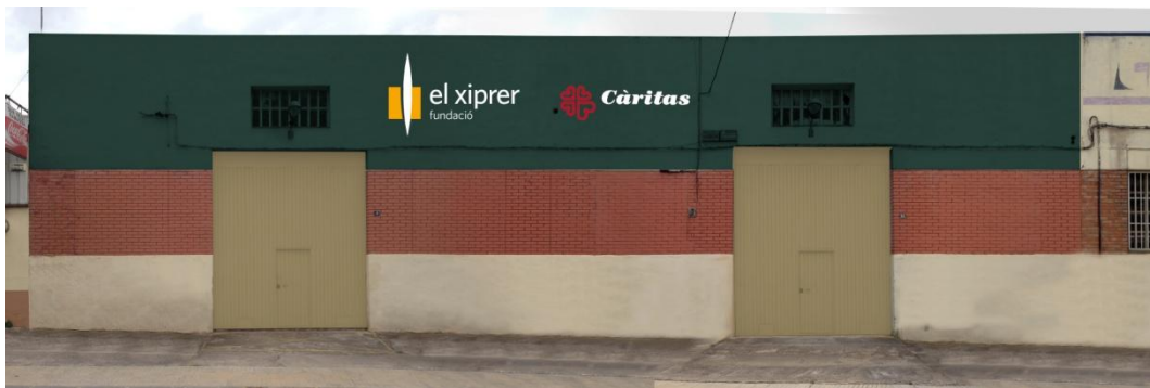
Façana del magatzem del Ramassar
